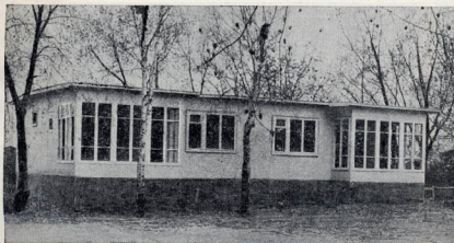
Экспериментальный жилой дом, изготовленный на Пермском ДСК
