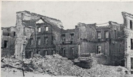
Разрушенные войной здания в центральной части города
