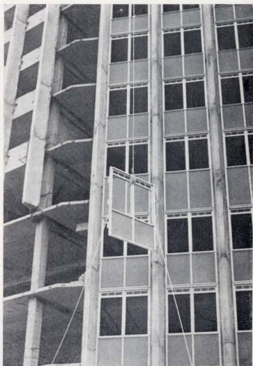
Дом торговли в Киеве. Монтаж панельных навесных стен
