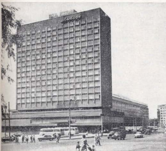
Гостиница «Лыбидь» в Киеве. Навесные стены из рамных элементов
