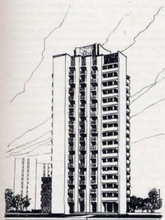
17-этажный жилой дом на Волгоградском проспекте, возведенный в скользящей опалубке. Архитекторы А. Белокоп, Н. Грачева, инженеры А. Лурье, Я. Цирик, М. Галкин
