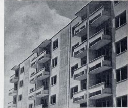
Город Скопье [СФРЮ]. Фрагмент крупнопанельного жилого дома, возводимого заводом КПД, переданным СССР в дар городу Скопье
