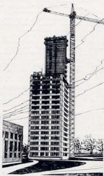
Строительство 25-этажного жилого дома на 2-м Сетуньском проспекте. Архитекторы Е. Стало, О. Кедровский, Р. Былинкина, инженеры Ю. Дыховичный, А. Шинкаревский
