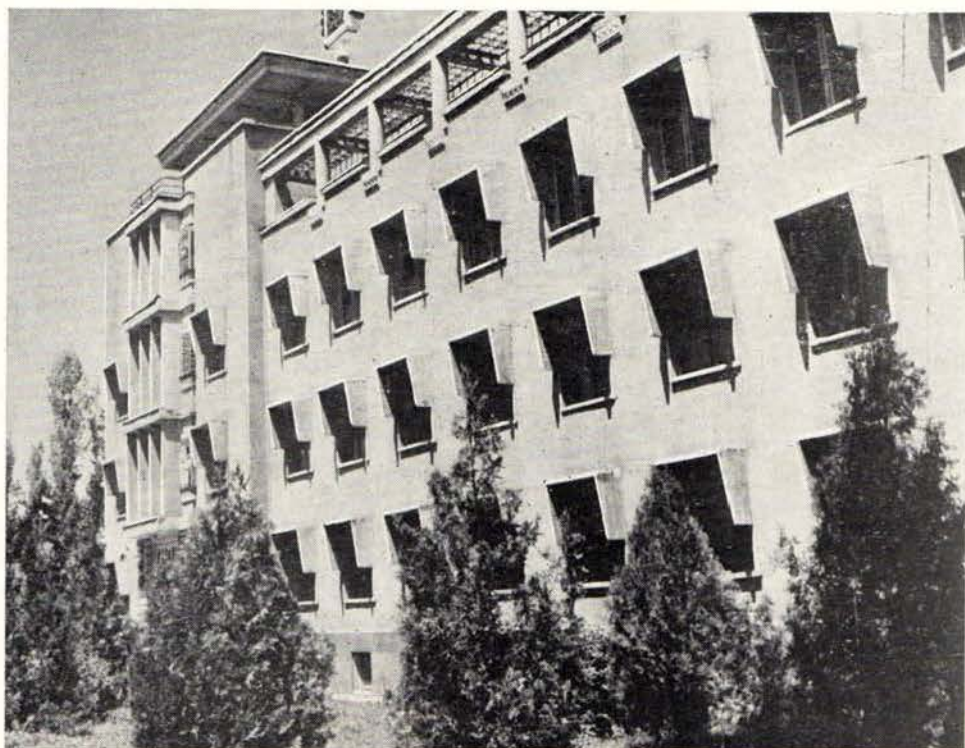
Один из корпусов Академии наук Киргизской ССР. Архитекторы Ю. Билинский, А. Бочаров. 1963 г.
