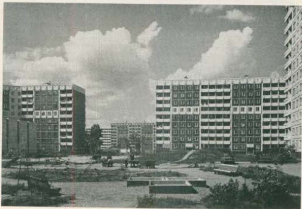
Застройка в районе ул. Челюскинцев
