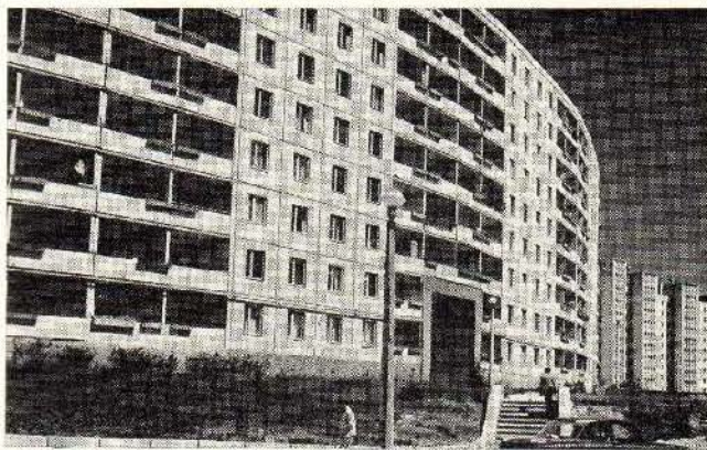
Жилой район Виноградарь (фрагмент). Коллектив под руководством архитектора Э. Бильского. 1968—1982 гг.
