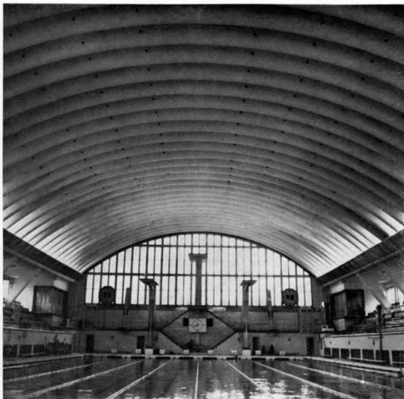
Плавательный бассейн СКА в Ленинграде. Армозементный вогнутый свод пролетом 30 м Авторы — архитекторы С. Елдокимов, А. Изотко, инженеры В. Минин, Л. Онежский
