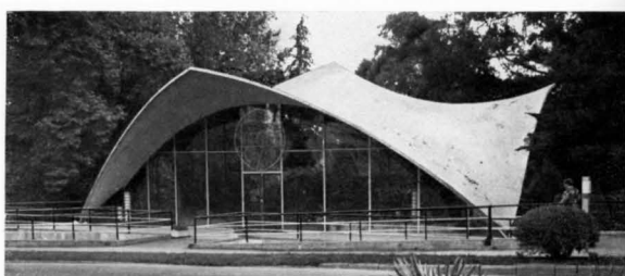
Ресторан в Паланге (Литовская ССР). Железобетонная грибовидная оболочка Автор — архитектор А. Ейгирдас
