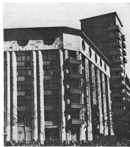
1933, № 1. Уширившая и жилой корпус на улице Дзержинского. Архитекторы И. Фомина, А. Лангман
