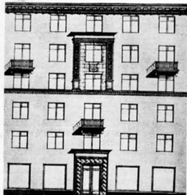
1939, № 5. Фрагмент фасада типового дома для скоростного строительства в Москве. Архитектор А. Мордвинов
