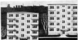
1962, № 8. Типовой секционный дом серии 1-464А. Фасад. Проект разработан ЦНИИЭП-Жилища
