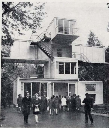
Композиция, демонстрирующая архитектурные и конструктивные особенности применения объемных блоков Краснодарского технического направления. Москва, Парк «Сокольники», 1970 г.
