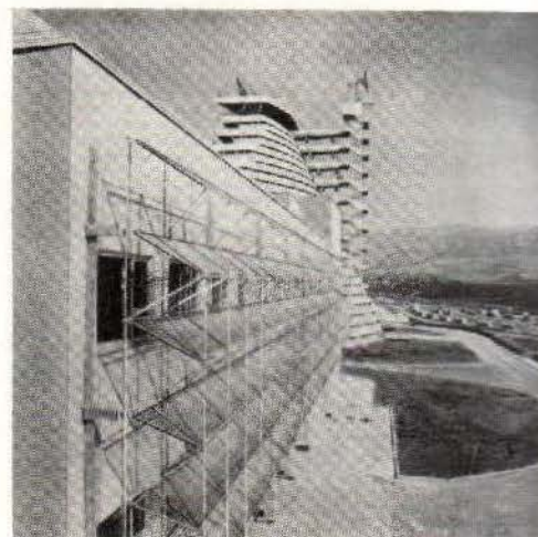
Фрагмент солнцезащиты южного фасада
