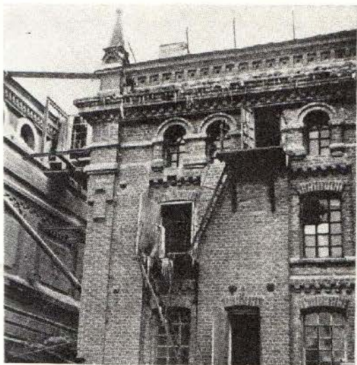
Мукомольный завод. Бывшая мельница Башкирова. Современное состояние
