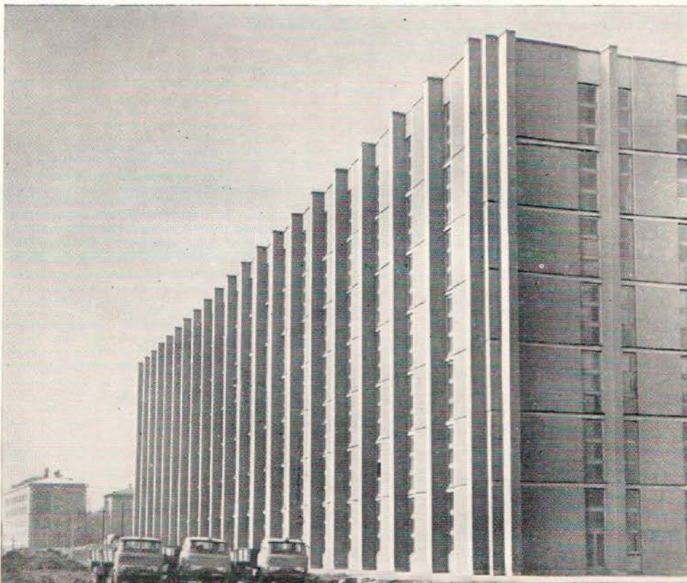
Ленинградское электромашиностроительное объединение «Электросила». Испытательная станция мощных турбогенераторов
