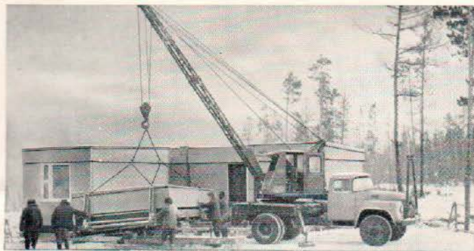
Монтаж здания из блок-пакетов в пос. Нерюнгра Якутской АССР
