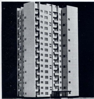
Шестнадцатизатяжный 80-квартирный панельный жилой дом П 6/16. Мастерская № 2, руководитель К. Метельский Манет и план типового этажа
