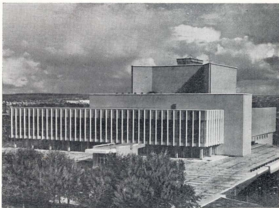
Новосибирск. Дворец культуры им. Чкалова. Архитектор М. Пирогов, инженер Г. Кудашев
