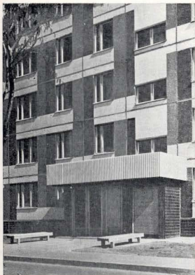
Тушино. 12-этажный крупнопанельный дом. Фрагмент фасада
