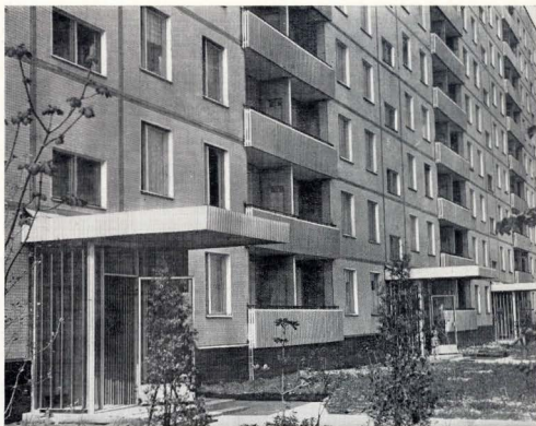
10 квартал Новых Черемушек. Крупнопанельный 9-этажный дом. Фрагмент фасада
