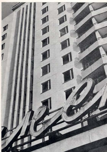
Давыдково. Корпус 5. Фрагмент фасада
