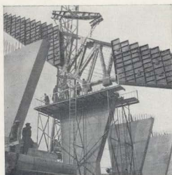
Каркас и опалубка ригелей под трибуну второго яруса западной трибуны
