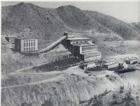
Обогатительная фабрика Агаракского медно-молибденового комбината. Архитекторы Э. Григорян, Л. Гаспарян, С. Акшерян, инженеры, А. Аракелян, А. Козманиян, В. Саркисян
