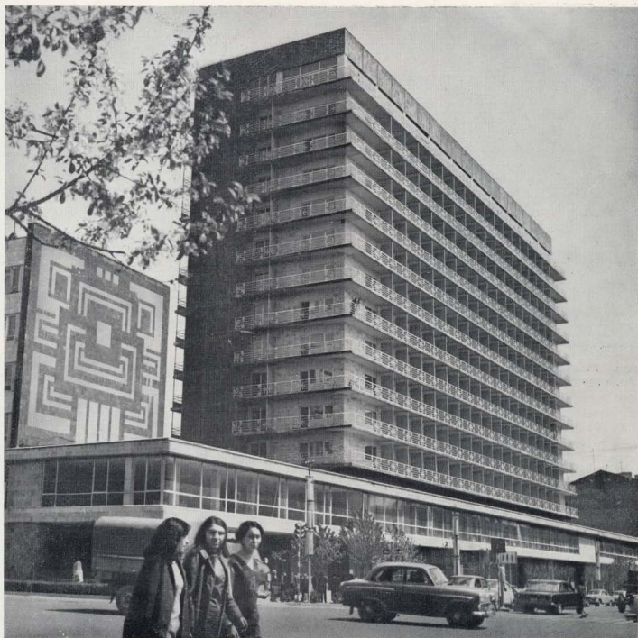
Ереван. Гостиница «Ани». Архитекторы Ф. Дарбинян, Э. Сафарян, Ф. Акопян, ин- женер Г. Бальян
