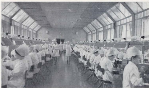
Часовой завод в Минске. Сборочный цех
