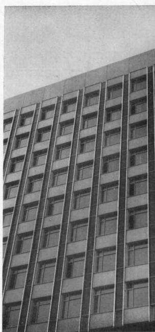
Облицовка здания алюминиевым листом и темалитом
