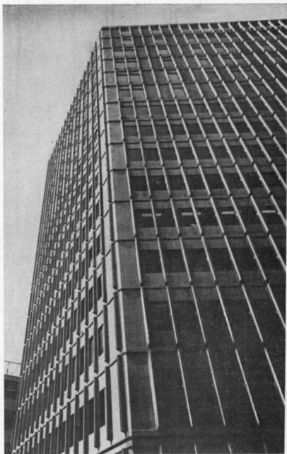
Облицовка здания алюминиевым листом и стемалитом
