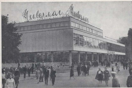
Торговый комплекс в Эссентуках. Архитекторы Л. Рагозина, Г. Турок, Е. Бобылев, инженер Р. Короленко
