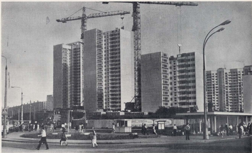
Тропарево. 22-этажные панельные дома, строящиеся из изделий Единого унифицированного каталога МНИИТЭП, маст 3
