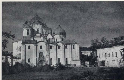
Новгород. Софийский собор с поврежденными стен и куполов Фото М. Рзянина
