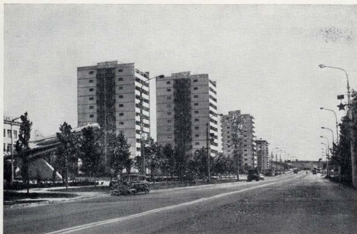
Новый жилой район Севастополя, ул. Острякова. Первые жилые дома повышенной этажности. Архитектор В. Щербинина
