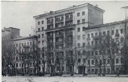
Жилой дом на Чистых прудах в Москве. Архитекторы М. Шерфединов, М. Пекарев, 1936—1941 гг.
