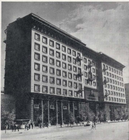
Жилой дом на Краснопрудной улице в Москве. Архитекторы Ю. Мухаринский, И. Рожин
