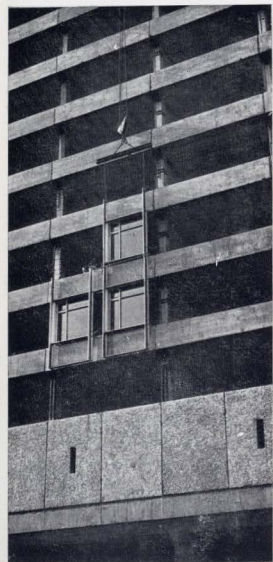
Здание Института стали и сплавов в Москве. Крепление рамных элементов алюминиевого каркаса к легкобетонным панелям Здание Института стали и сплавов в Москве. Фрагмент фасада в стадии строительства
