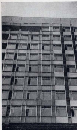
Здание Института стали и сплавов в Москве. Крепление рамных элементов алюминиевого каркаса к легкобетонным панелям Здание Института стали и сплавов в Москве. Фрагмент фасада в стадии строительства
