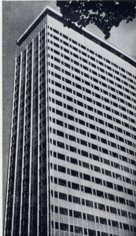
Гостиница «Латвия» в Риге. Навесные стены состоят из глухих полосовых панелей и ленточного остекления
