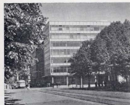
Здание Гипроторга в Риве. Навесные каркасные стены
