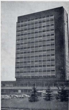
Здание института научно-технической информации в Киеве. Навесные стеновые панели высотой на два этажа
