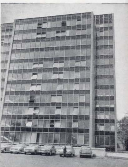
Здание Министерства меллиорации и водного хозяйства Литовской ССР в Вильнюсе. Наружные ограждающие конструкции представляют собой каркасную стену
