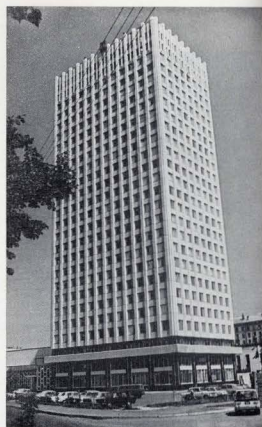
Москва. Новое здание Мосгипротранса на ул. Павла Корчагина
