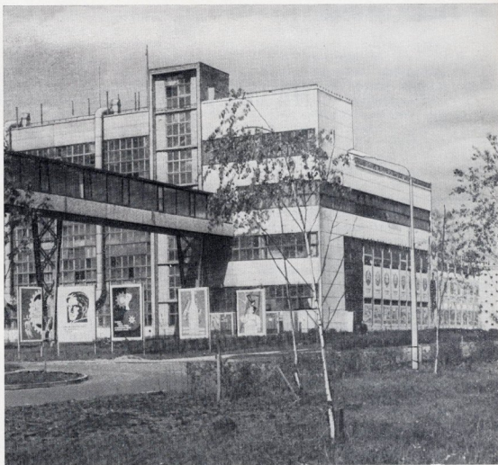
Комбинат синтетического волокна в Могилеве. Архитекторы В. Белашова, Н. Удалов, инженер Р. Шапиро [Гипроин]
