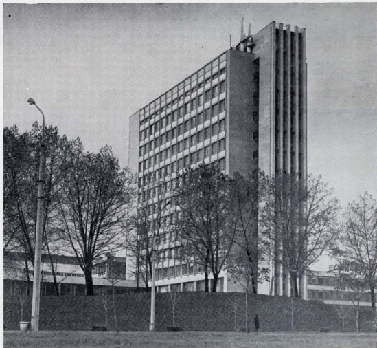
Инженерный корпус завода холодильников в Минске.
