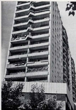
14-этажный жилой дом из вибропротатных панелей с торговыми предприятиями в первом этаже на Русаковской улице. Архитекторы А. Самсонов, А. Бергельсон, МНИИЭП; архитекторы В. Нестеров, А. Павликов, А. Андреев, Моспроект-1
