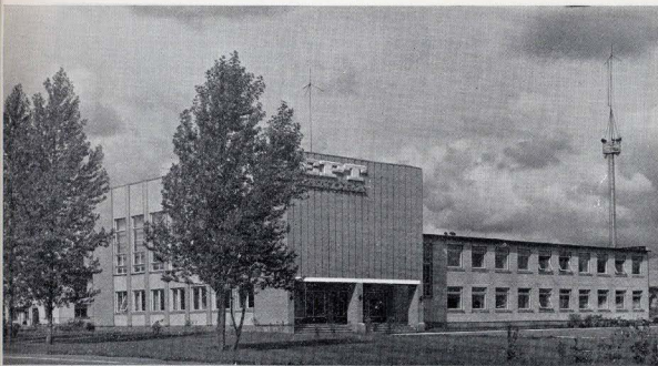
Административное здание объединения Эстсельхозтехника. Архитектор Э. Лийберг, инженер А. Кокс [Эстпромпроект]
