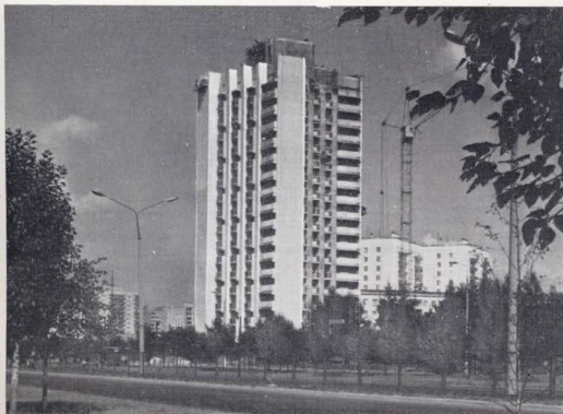
Москва. Жилой дом из монолитного железобетона, возводимый методом скользящей опалубки на Волгоградском проспекте
