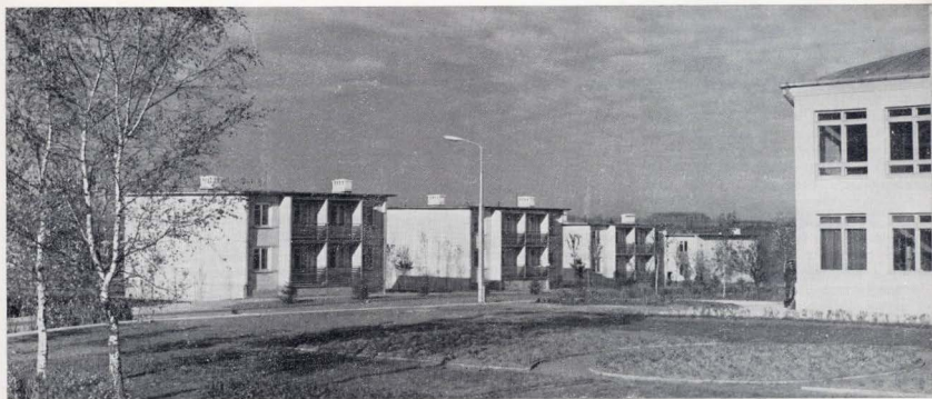
Двухквартирные жилые дома из крупных газосиликатных панелей в поселке Ленино
