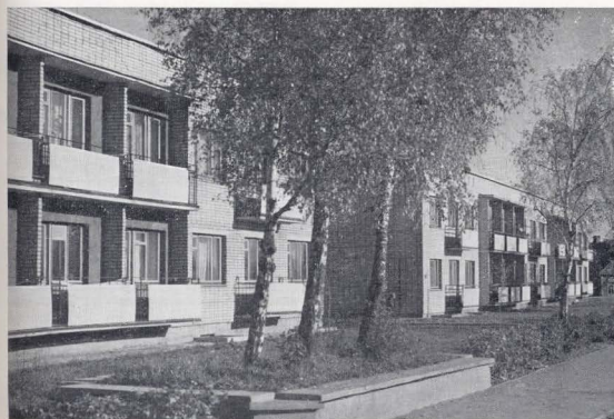
18-квартирные жилые дома в пос. Ленино
