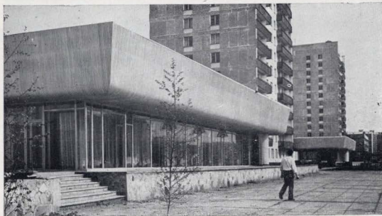
Блоки торгового обслуживания в I жилом районе
