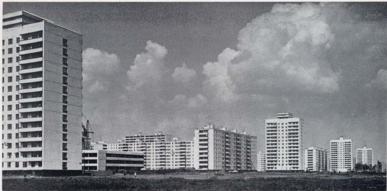
Застройка проспекта Мира
