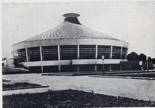
Цирк в Алма-Ате. Авторы: архитекторы В. Кацев, И. Слонов; инженеры С. Матвеев, М. Плахотников
