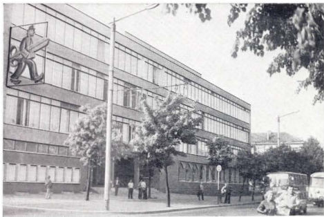
Дом быта в Каунасе. Архитектор А. Микенас [Литпромпроект]
