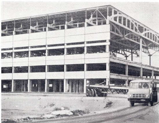
Строительство первой очереди блока завода электроннагревательных приборов
