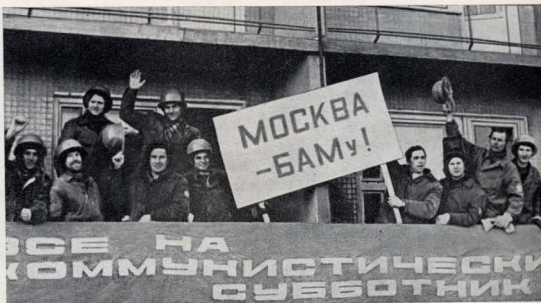
Рабочие Главмостроя на Коммунистическом субботнике в г. Тынды
