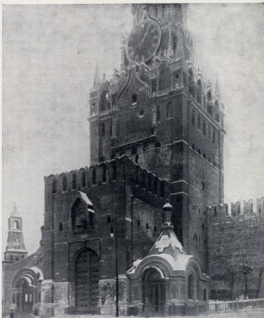
Спасская башня со следами повреждения снарядами, часы тоже повреждены попаданием снаряда в цифру II
