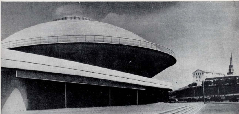
Цирк. Архитектор Г. Пичуев, инженер О. Берин
