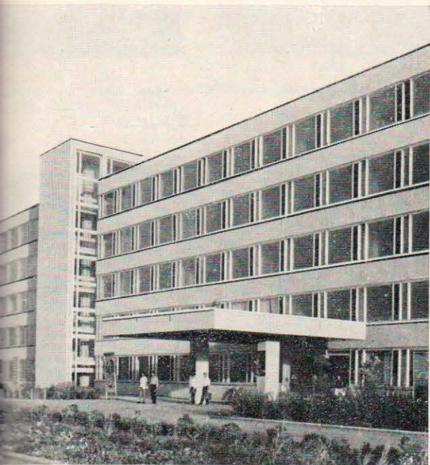
Главный учебный корпус Бухарского Государственного педагогического института. Построен в 1970 г. Архитекторы А. Беляев, О. Зимин, инженер В. Гоготов. Фрагмент главного входа в корпус
