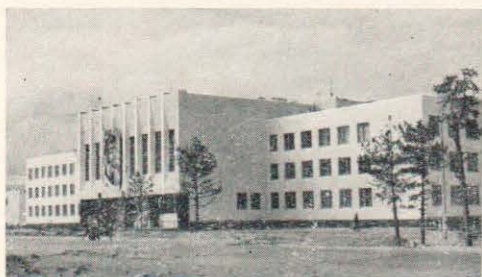
Здание школы на 764 места в г. Надыме
