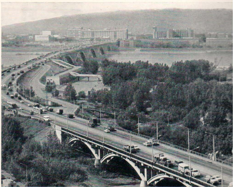
Красноярск. Мост через Енисей
