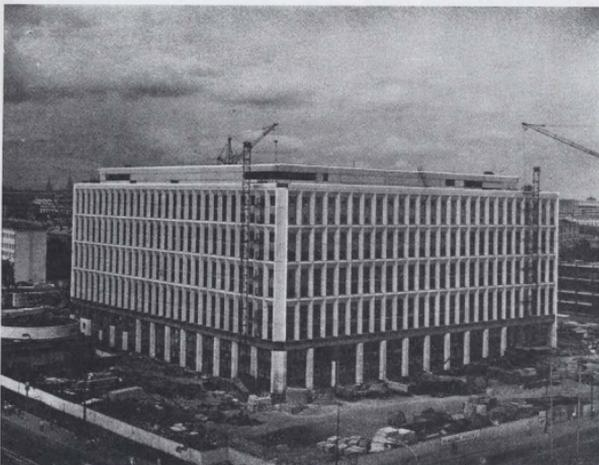
развитие, явился выбор статической схемы каркаса как связевой вместо наиболее распространенных рамных и рамно-связевых систем. Такое решение пришло не сразу, так как считалось, что связевые системы ограничивают возможности в решении архитектурных и функциональных задач.
