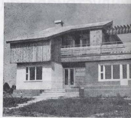
Экспериментальный жилой дом с квартирами в двух уровнях из бетонных блоккомнат и облегченных клефанерных панелей в совхозе «Минский» Минской области
