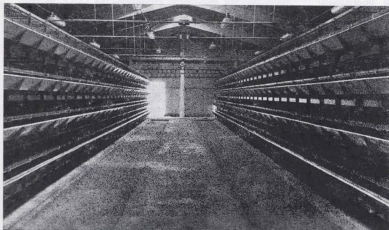
Минское производственное объединение по птицеводству. Отделение Дубовляны. Интерьер птичника из индустриальных строительных конструкций облегченного вида
