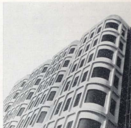
Обработка сборных железобетонных элементов зернистыми фактурами усиливает выразительность их форм. Лондон а — многоэтажный гараж; б — административное здание
