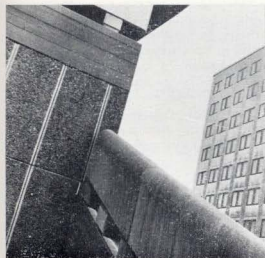
Соединение разных типов декоративной обработки поверхностей бетонных элементов обогащает архитектурную композицию
