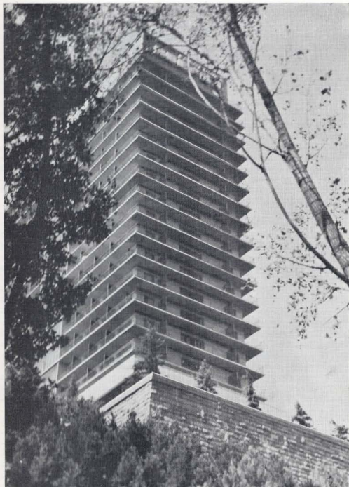
Железобетонные опоясывающие балконы придают особую легкость силуэту объема. Тбилиси
