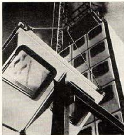
Монтаж панелей со стеклопластиковой облицовкой
