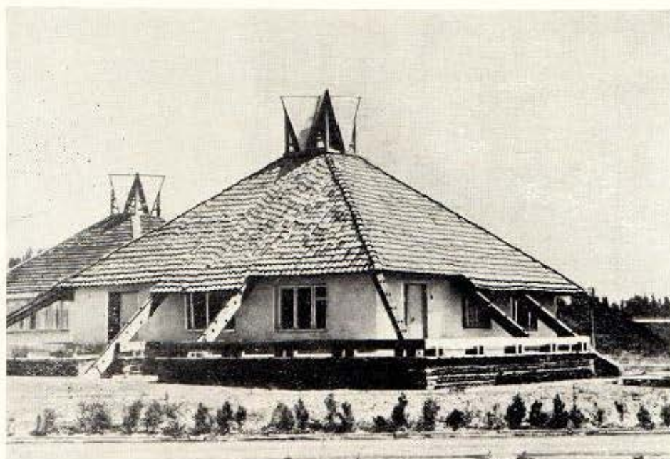
Детские ясли-сад на 70 мест в поселке Меджврисхеви Горной птицефабрики Грузинской ССР а — общий вид; б — план;
