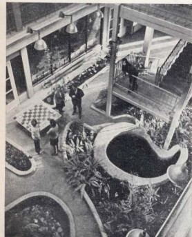
Прокатный стан «2500». Бытовые. Архитектор Н. Волобуева
