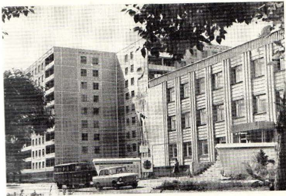
Новое здание на одной из первых улиц города Комсомольска-на-Амуре — Краснофлотской
