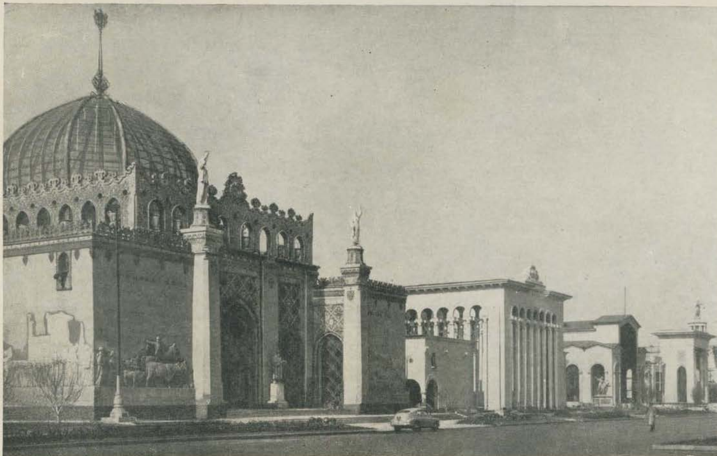
Павильон Казахской ССР (на переднем плане). Общий вид и план. Архитекторы И. Петров, Н. Куприянов и Т. Басенов при участии М. Александровской. Конструктор Г. Кадошников
