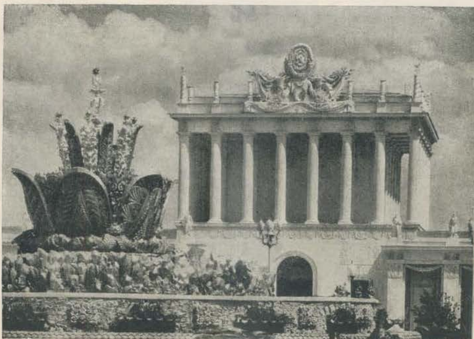
Павильон Молдавской ССР. Общий вид и план. Архитекторы Ф. Наумов, А. Захаров, В. Туканов
