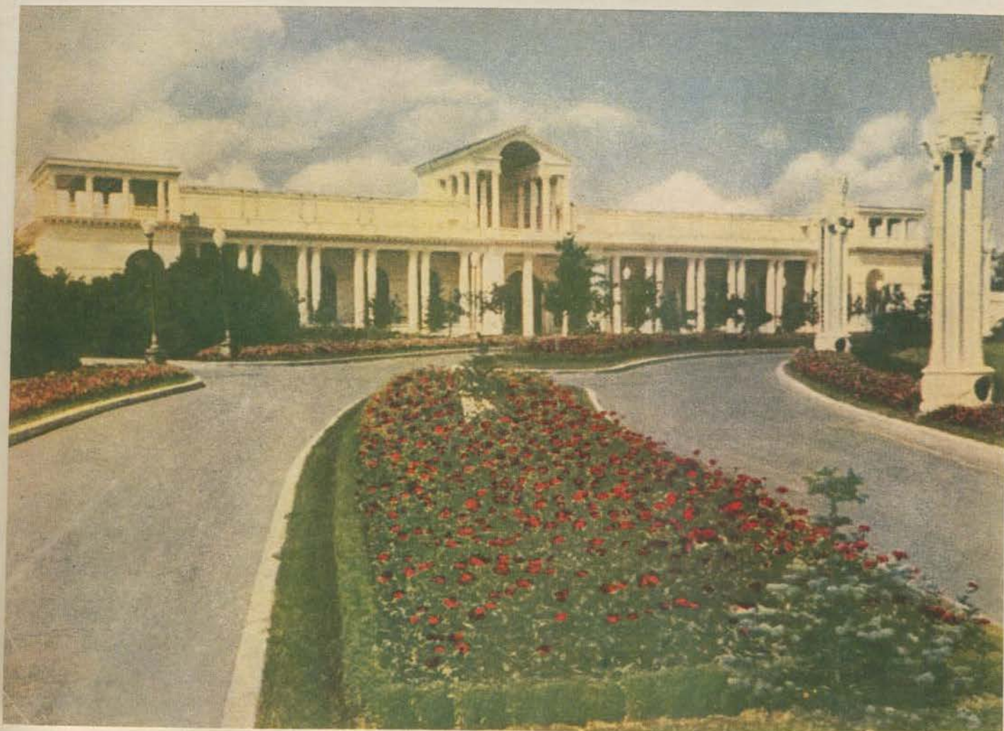
Здание ресторана. Архитектор А. Ефимов. Конструктор Н. Горин
