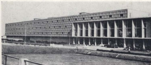
Высшая техническая школа в Камбодже. Общий вид и интерьер вестибюля
