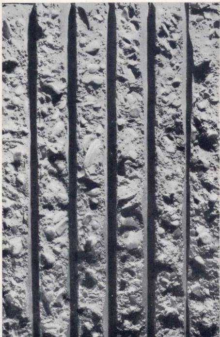
3. Декоративный бетон с обнаженным заполнителем
