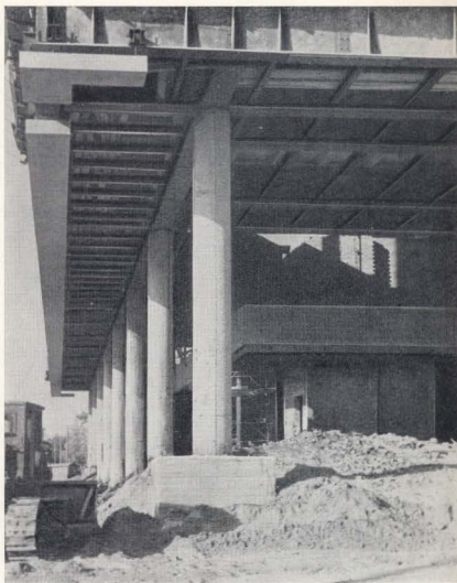
Строительство здания Ленинского Мемориального центра
