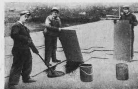
Рис. 14. Процесс укладки плит оргалита (целотекса) для утепления крыши
