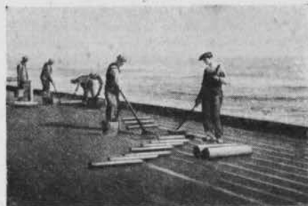
Рис. 13. Процесс укладки рулонного ковра по деревянному основанию. Для удобства укладки рулонов последние имеют прочерченные краской линии, указывающие границу покрытия рулона клебемассой
