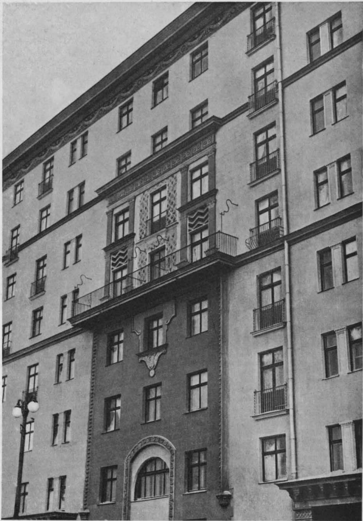
Жилой дом на Б. Калужской улице. Фрагмент главного фасада
