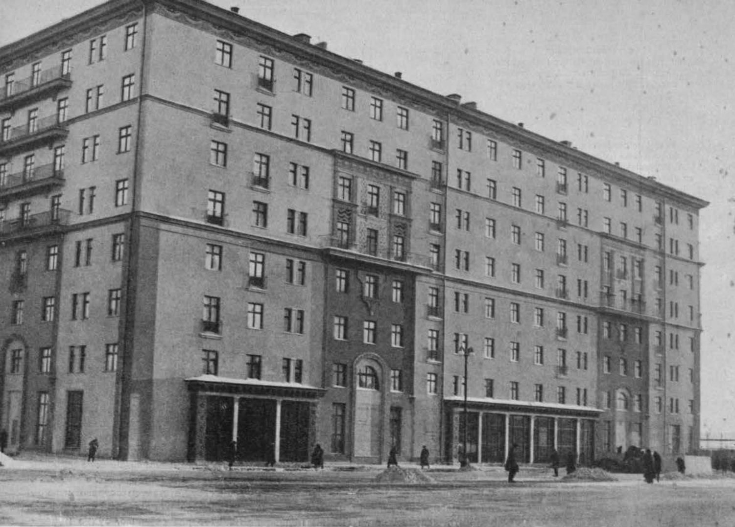
Жилой дом на Б. Калужской улице в Москве. Арх. М. Г. Бархин Maison d'habitation rue Grande Kaloujskaia à Moscou. Arch. M. G. Barkhine
