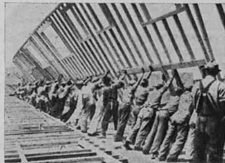
Установка каркасных стен двухэтажных сборных домов в поселке фирмы «Дженерал электрик»
