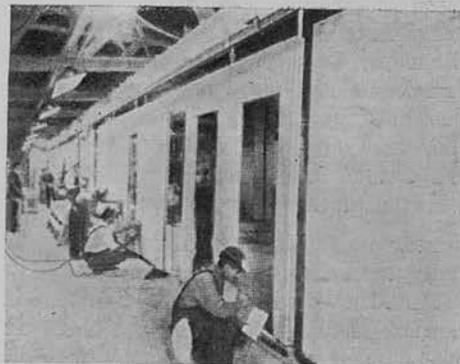
Сборка домов фирмы «Нэйшенэл». Стеновые щиты в вертикальном положении разгружаются прямо с автомашины на подготовленный пол дома
