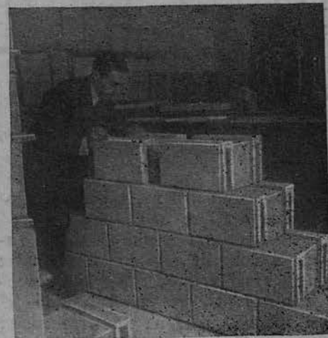
Опытная кладка из блоков
