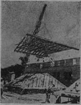
17. Строительство поселков индустриально-механизированными методами. Крыша, собранная из заранее фабрично-изготовленных элементов, водружается мощным краном на здание
