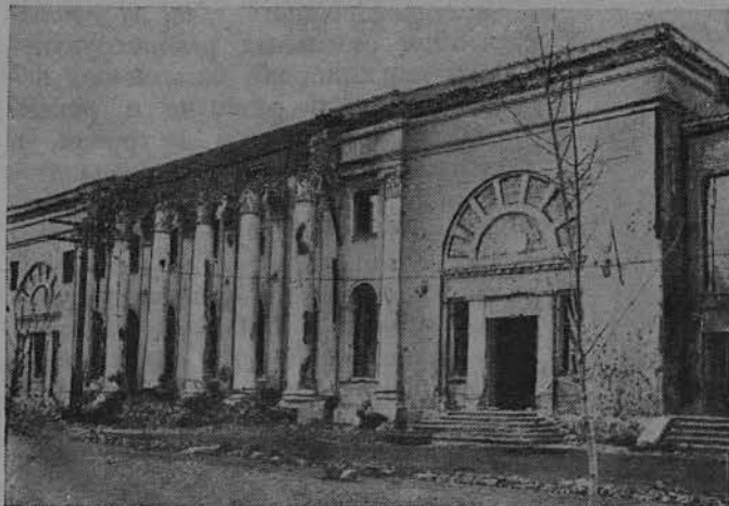
Воронеж. Разрушенное здание филармонии
