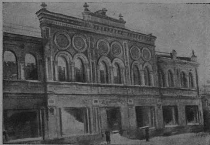
Разрушенный дом на Базарной площади
