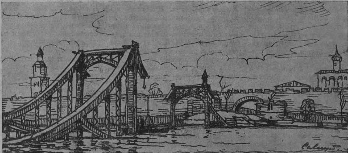
Новгород. Разрушенный мост через Волхов. Рис. Д. Савицкого
