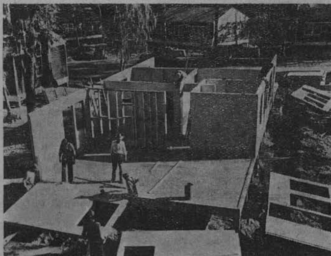
Постройка сборного дома для оборонного завода в США (метод сборки вертикальных стеновых щитов)
