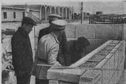
Стена из гипсовых плит
