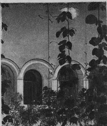
Корпус № 1. Фрагмент фасада
