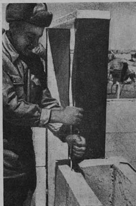
Сверление отверстий в плите
