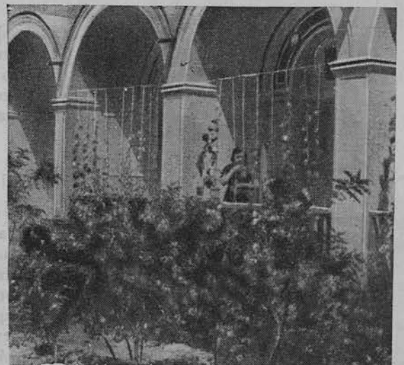
Корпус № 1. Фрагмент фасада
