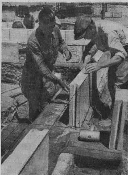
Укладка гипсовых плит
