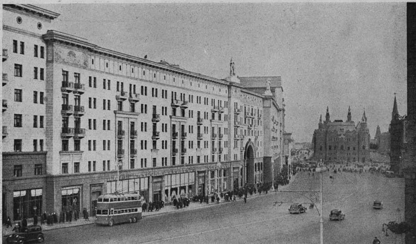
Москва, Улица Горького после реконструкции. Жилые дома. Арх. А. Мордвинев. 1938—41
