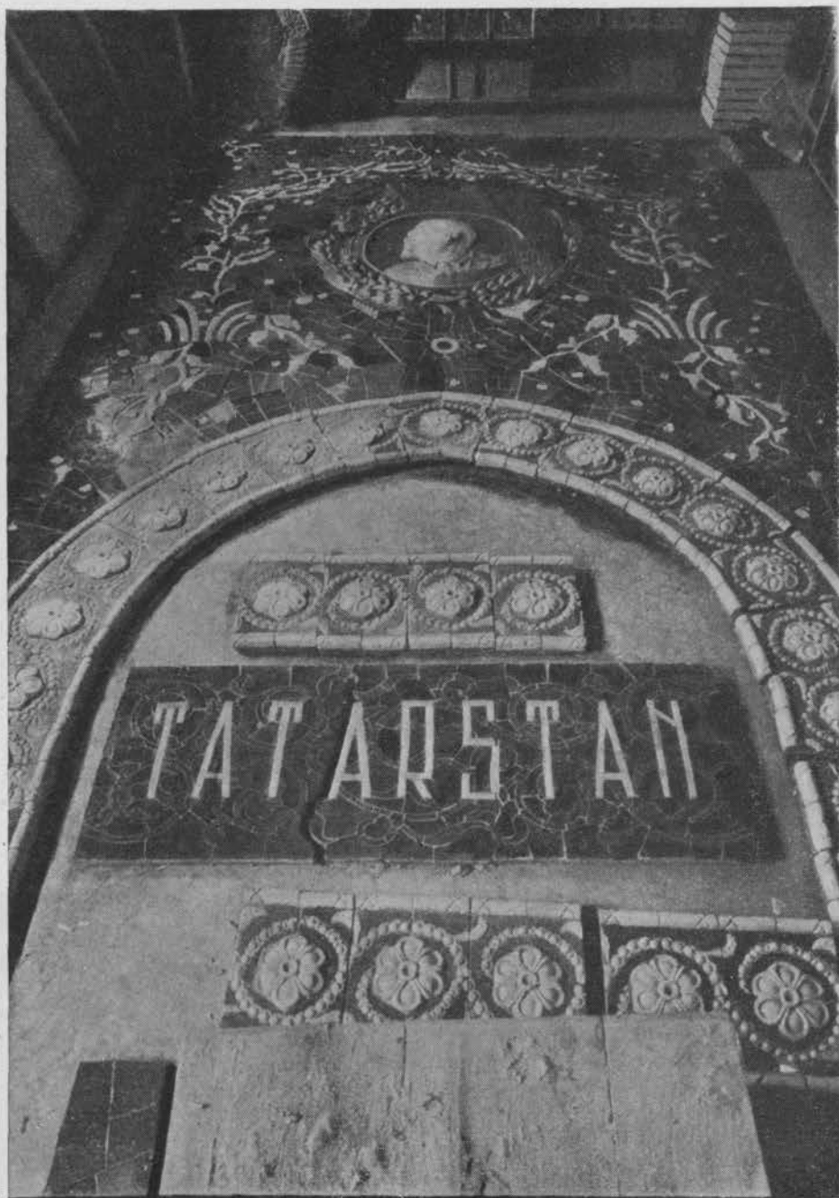
Сборка керамической облицовки для главного входа в павильон Татарской АССР на Всесоюзной сельскохозяйственной выставке
