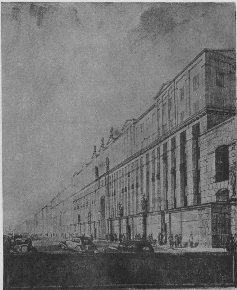
Г. П. Гольц. Эскиз жилого дома на ул. Горького в Москве. 1940 г. G. P. Goltz. Maison d'habitation rue Gorki à Moscou. Esquisse
