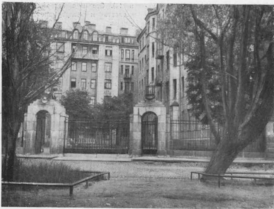
Рис. 12. Дом на набережной реки Карповки в Ленинграде. Глубокий курдонер (40 м), шириной 18 м
