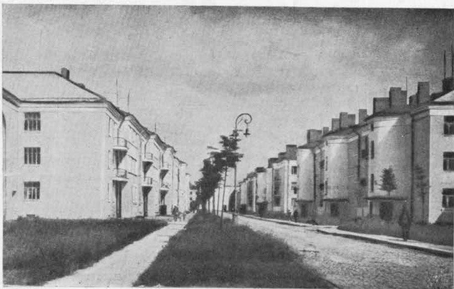
Застройка Тракторной улицы в Кировском районе Ленинграда. 1926—29 гг. Акад. арх. А. С. Никольский
