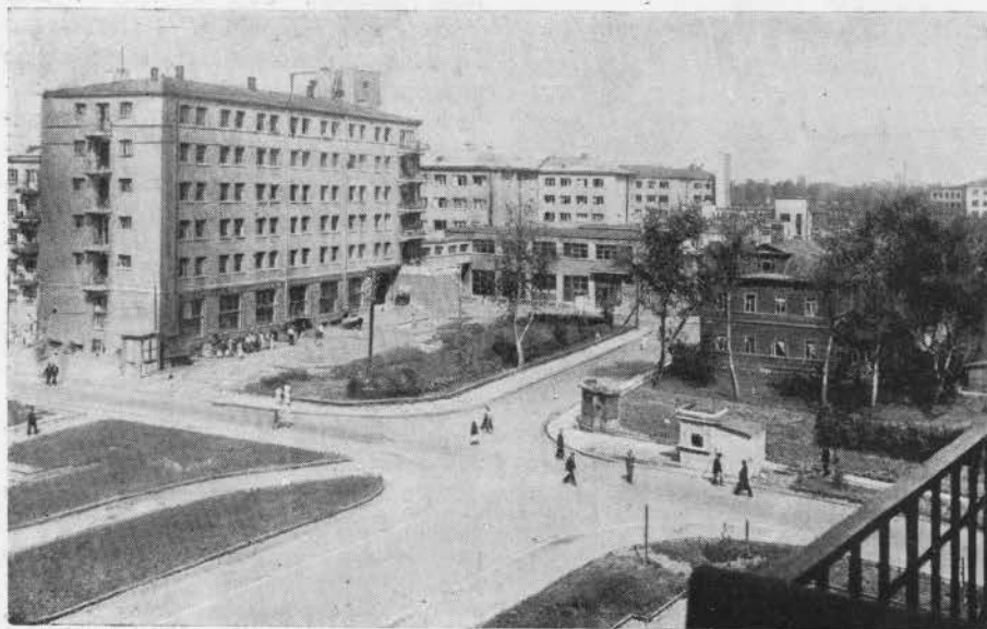
Жилой квартал на Турбинной улице в Ленинграде. 1930—31 гг.
