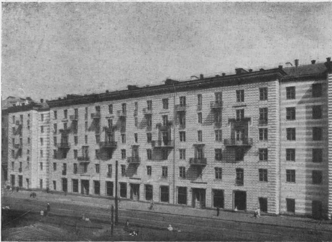
Жилой дом на Большой Полянке в Москве. Арх. А. К. Буров, Б. Н. Блохин Maison d'habitation rue Grande Polianka à Moscou. Arch. A. K. Bourov, B. N. Blokhine
