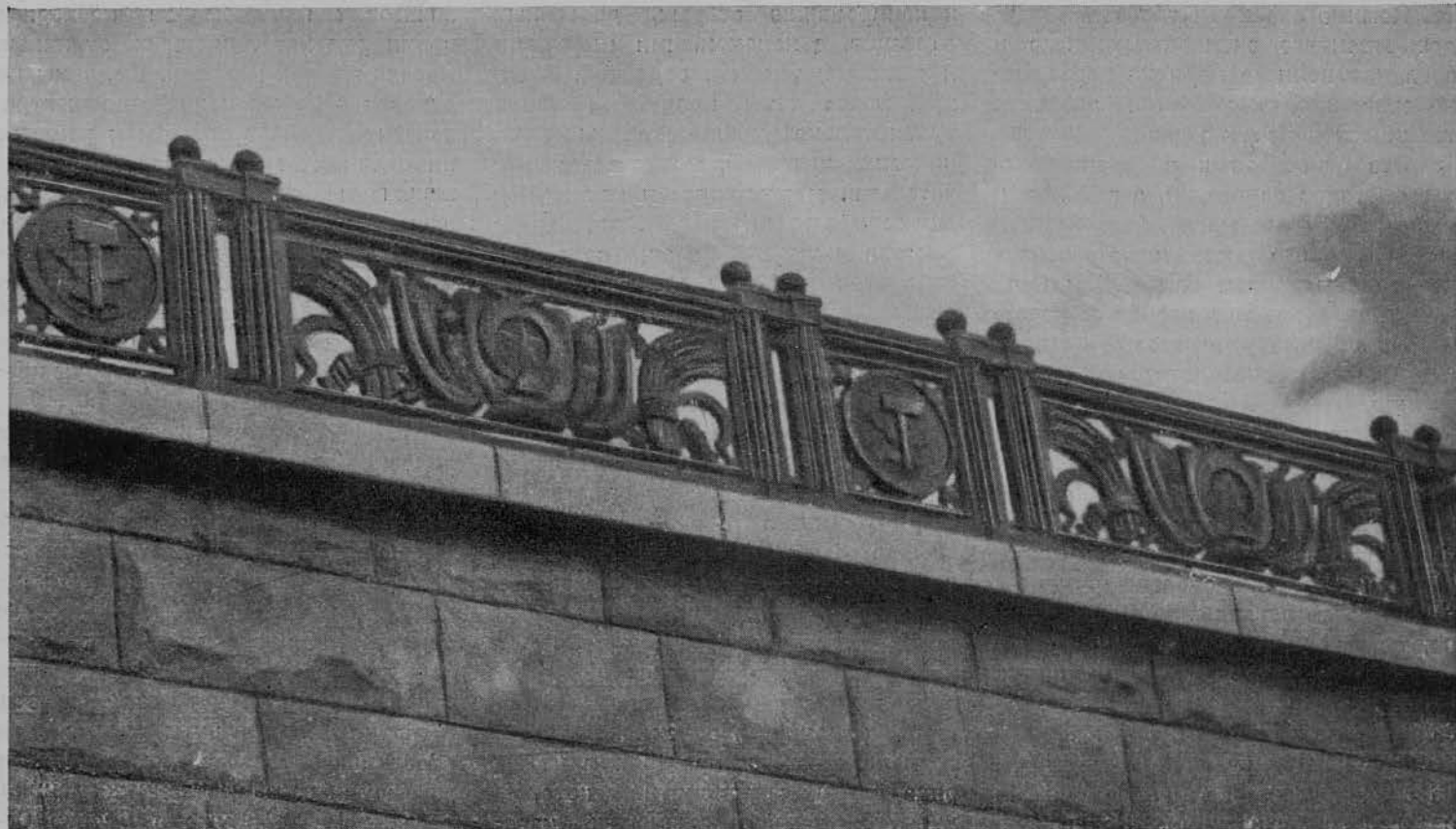
Перила Большого Каменного моста. Акад. арх. В. А. Шуко, проф. В. Г. Гельфрейх, арх. М. А. Минкус. 1936—1938 гг. Parapet du pont Grand Kamenni à Moscou. V. A. Schouko, membre de l'Académie, prof. V. G. Helfretch, arch. M. A. Minkous. 1936—38
