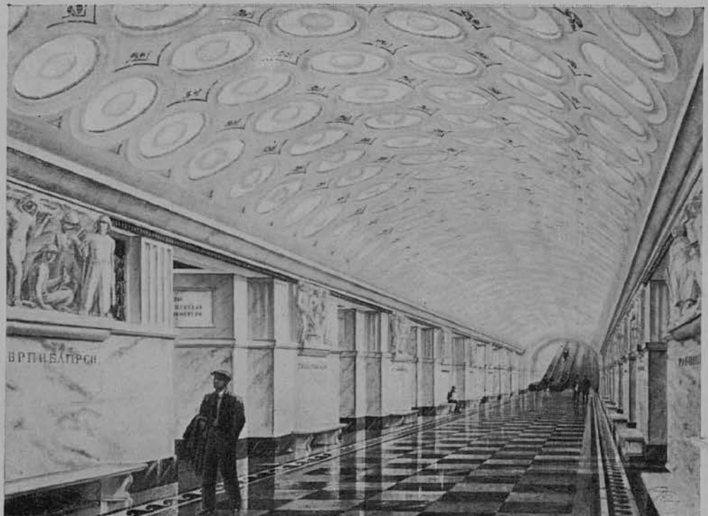
Станция метро «Электрозаводская». Центральный зал Station de métro „Electrozavodskaia“. Salle centrale
