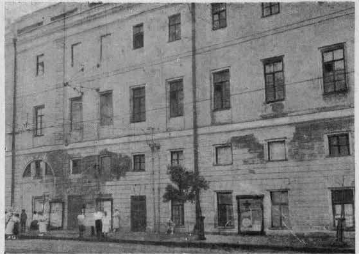
Слева: Инфильтрационное пятно вокруг балкона (здание Госбанка). Справа: Инфильтрационные пятна „закоренелого“ характера на старом здании. Вызваны гигроскопичностью поверхности вследствие наличия солей, вынесенных к поверхности штукатурки (здание Малого театра)
