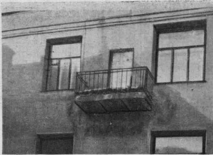
Слева: Инфильтрационное пятно вокруг балкона (здание Госбанка). Справа: Инфильтрационные пятна „закоренелого“ характера на старом здании. Вызваны гигроскопичностью поверхности вследствие наличия солей, вынесенных к поверхности штукатурки (здание Малого театра)
