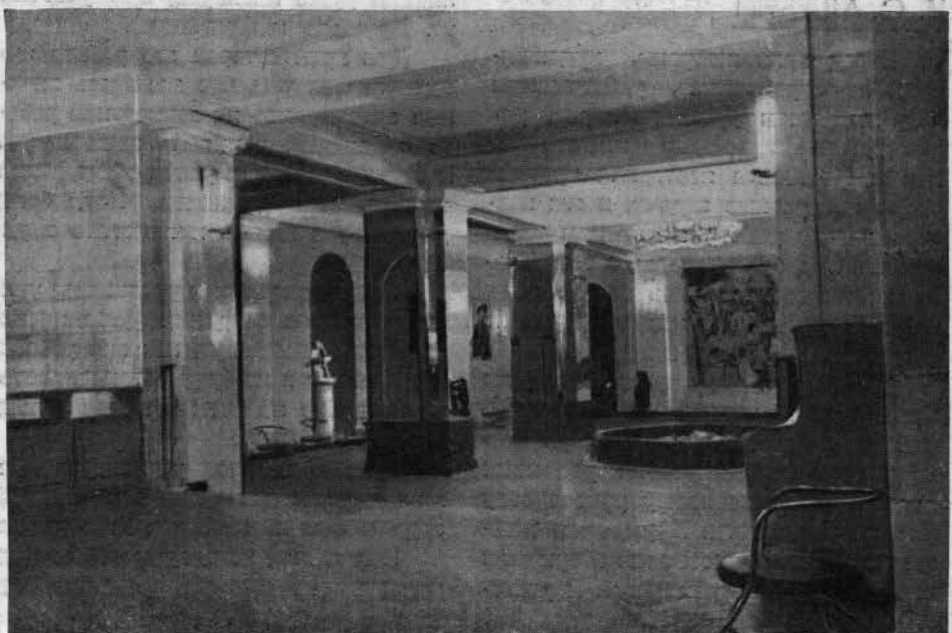
Vestibule du théâtre Arch. A. K. Tchaldymov
