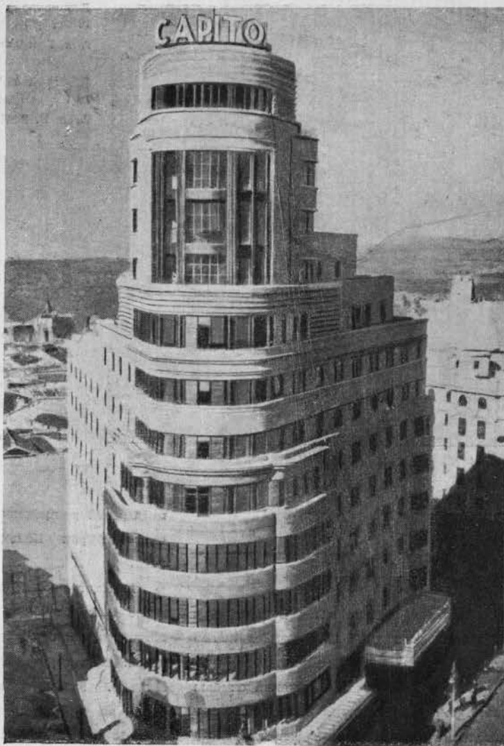
Cinéma „Capitol“ à Madrid. 1934 Vue générale Arch. L. Féduchl et V. Eesed
