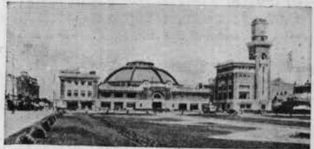
Центральный рынок в Плоешти, Румыния Арх. Т. Соколеско („La Construction Moderne“, № 46, 1936 г.)
