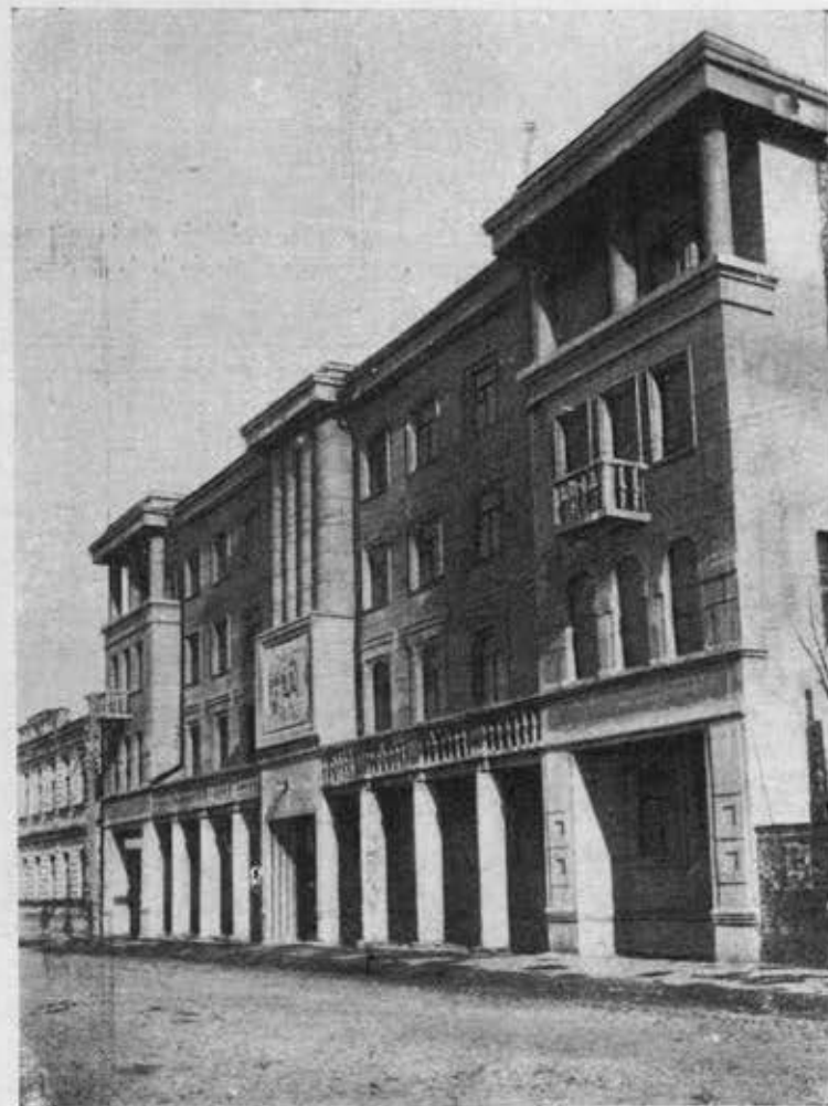
Здание Института марксистского заочного обучения „ИМЗО“ Арх. А. В. Миронов
