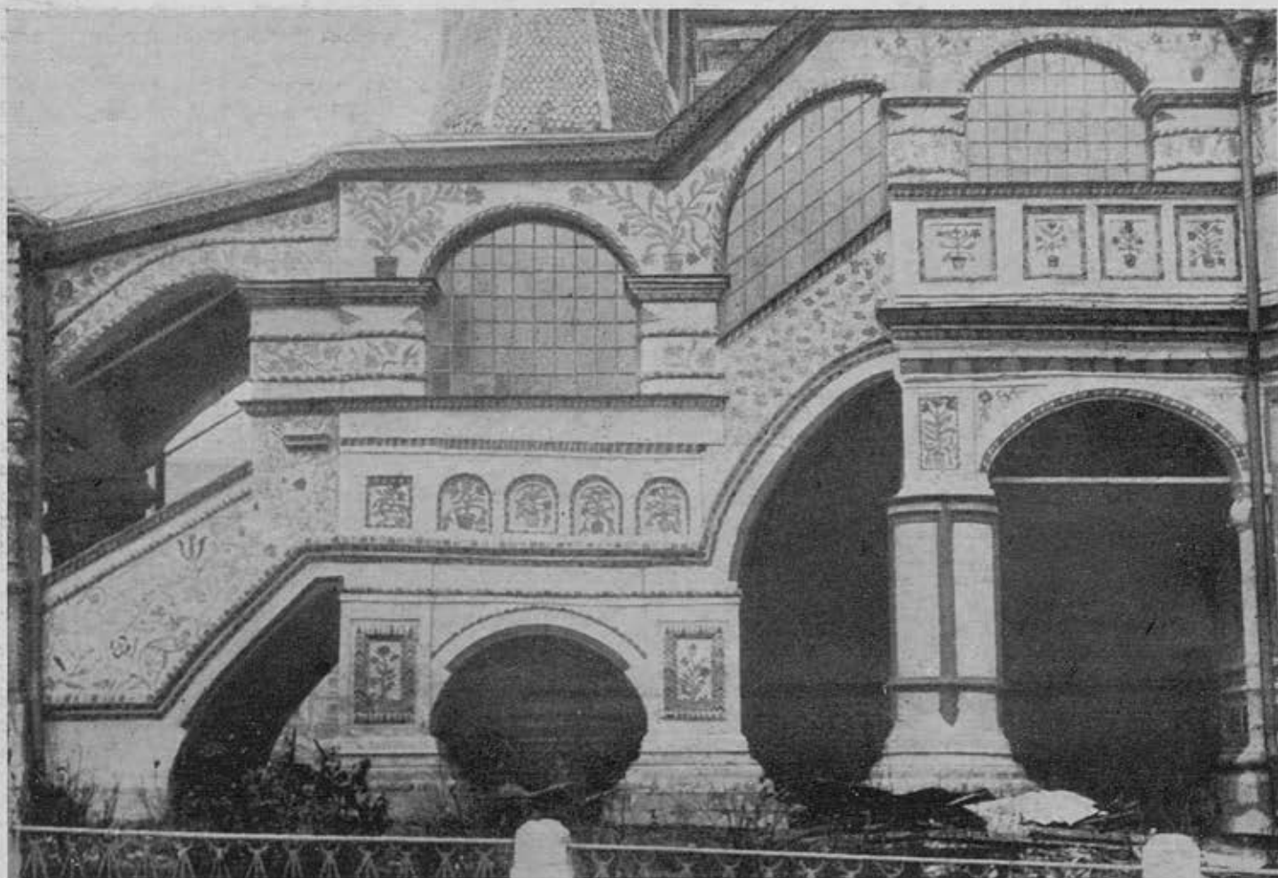
Западная галерея храма Реставрация и окраска 1937 г.
