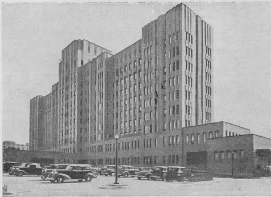
Американская больница на 475 коек в одном здании. Общий вид
