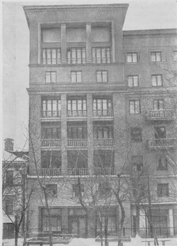
Détail de la façade
