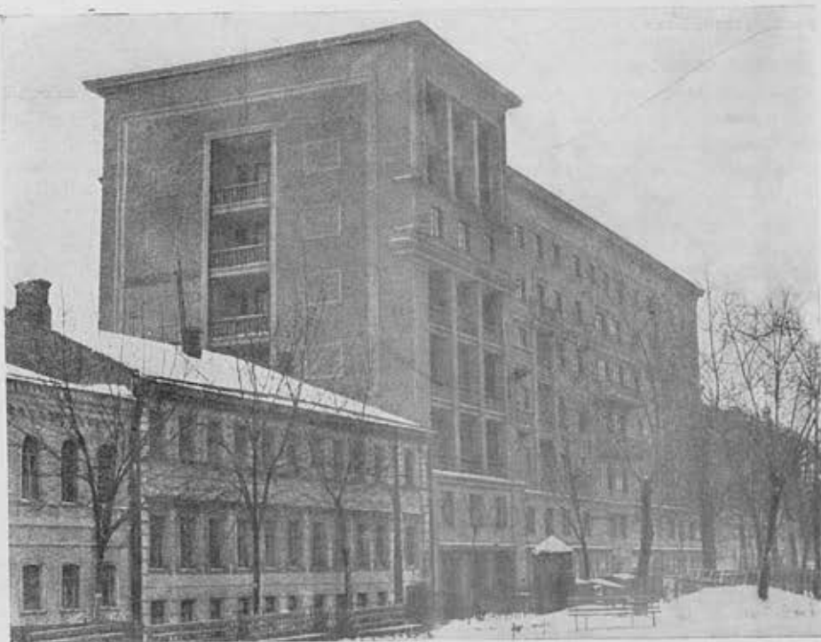
Жилой дом Наркомата связи на Сретенском бульваре в Москве Общий вид
