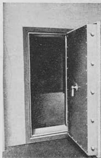
Металлические двери газоубежища
